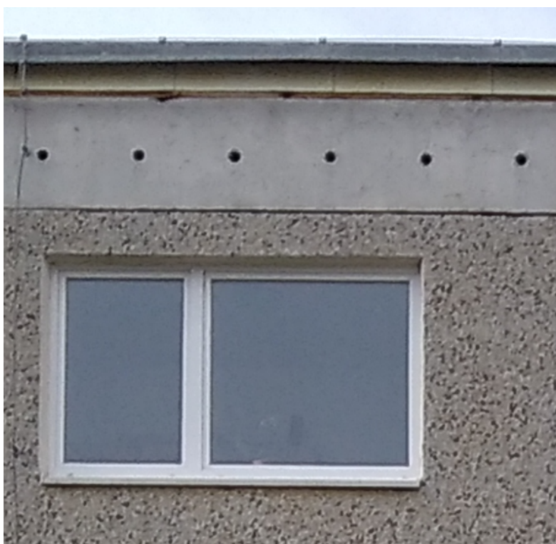
Obrázek 4 – Stávající větrací otvory střechy v atikovém panelu
