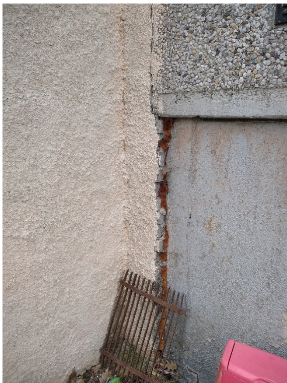
Obrázek 2 - Napojení dílny na sokl bytového domu
