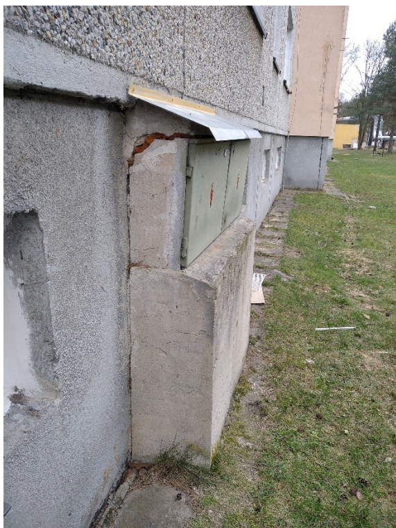
Obrázek 14 - Defekt pojistkové skříňě ve vlastnictví ČEZ Distribuce, a.s.
