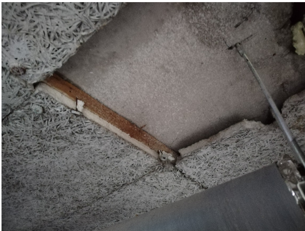
Obrázek 15 - Stávající dřevěný rošt se zateplením stropu nad 1.PP
