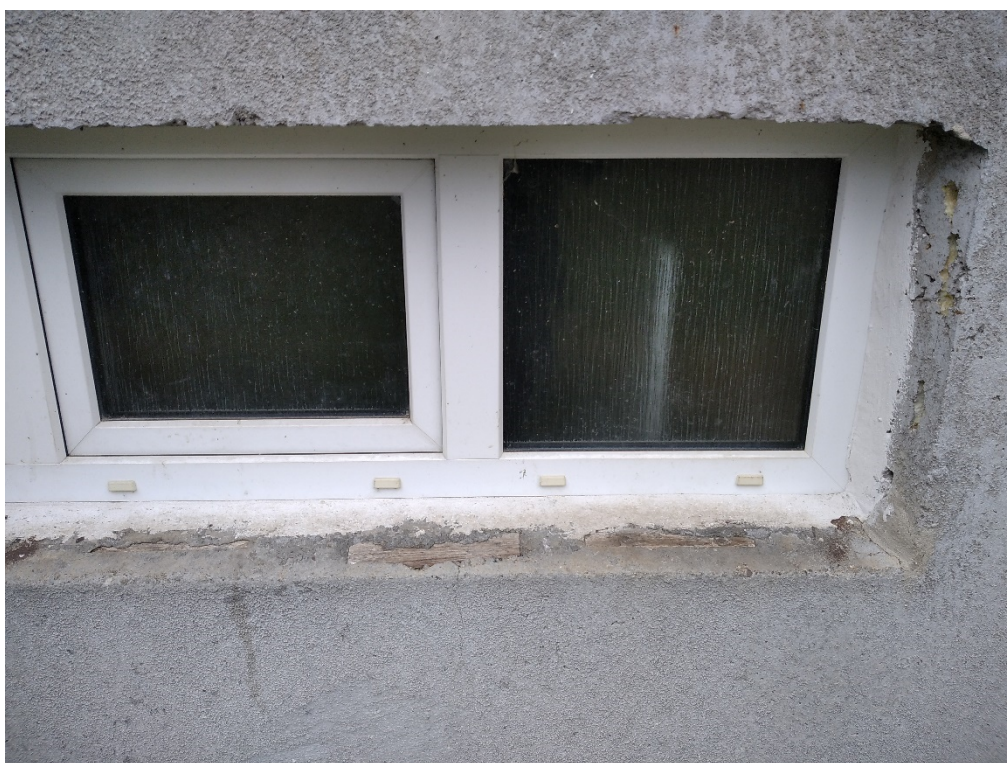
Obrázek 6 - Dřevěné špalíky parapetu a nepřesnost ostění
