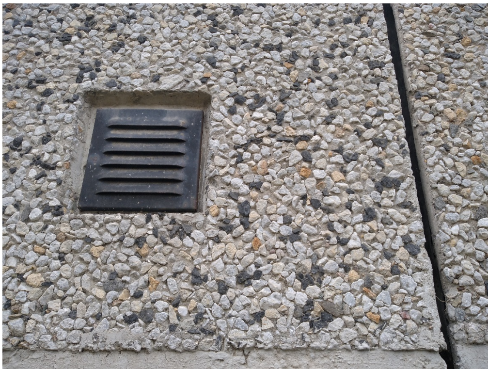
Obrázek 3 - Stávající větrací mřížka spíže v obvodovém panelu
