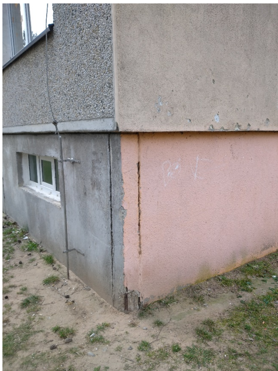
Obrázek 7 - Koroze výztuže v nároží
