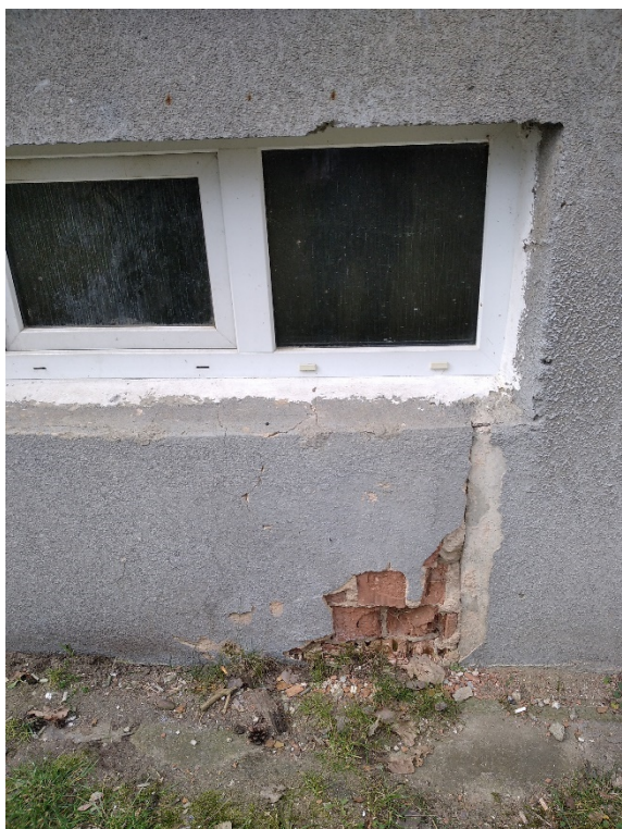
Obrázek 5 - Narušená dozdvívka parapetu z děrových cihel
