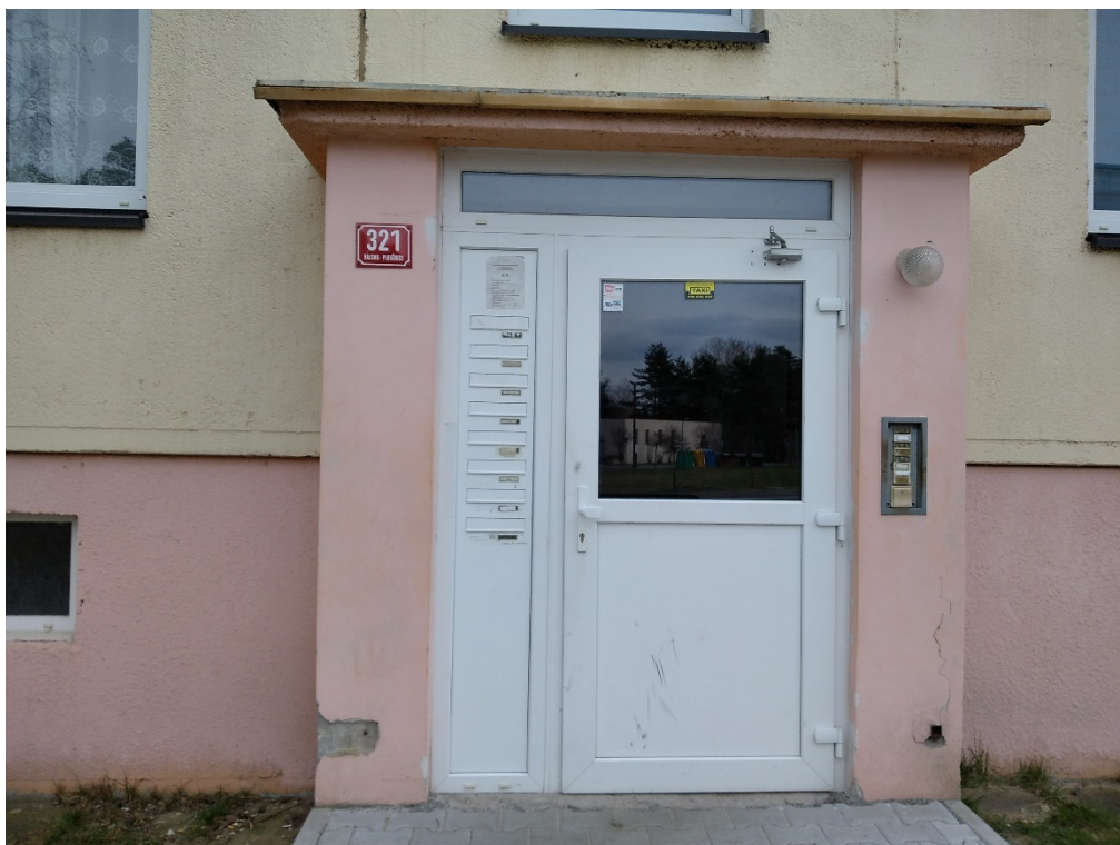
Obrázek 8 - Stávající narušená dozdivka vstupu
