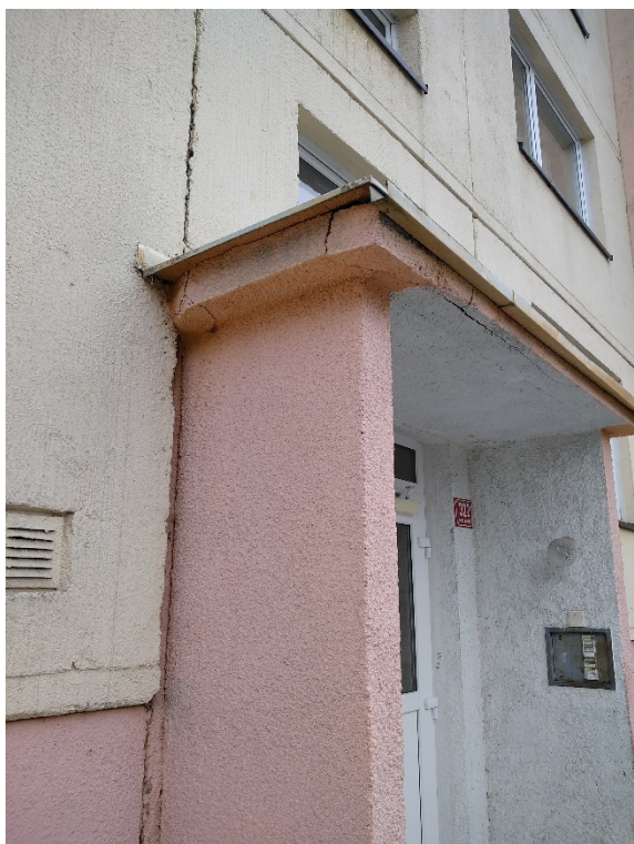
Obrázek 12 – Trhliny ve stávajícím stropním panelu vstupu
