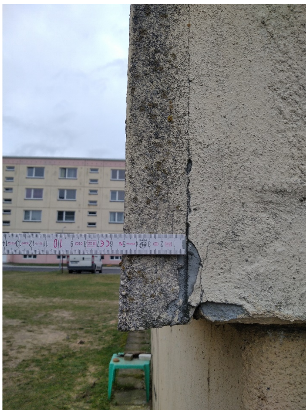
Obrázek 9 – Stávající KZS štítu narušený biologickými činiteli
