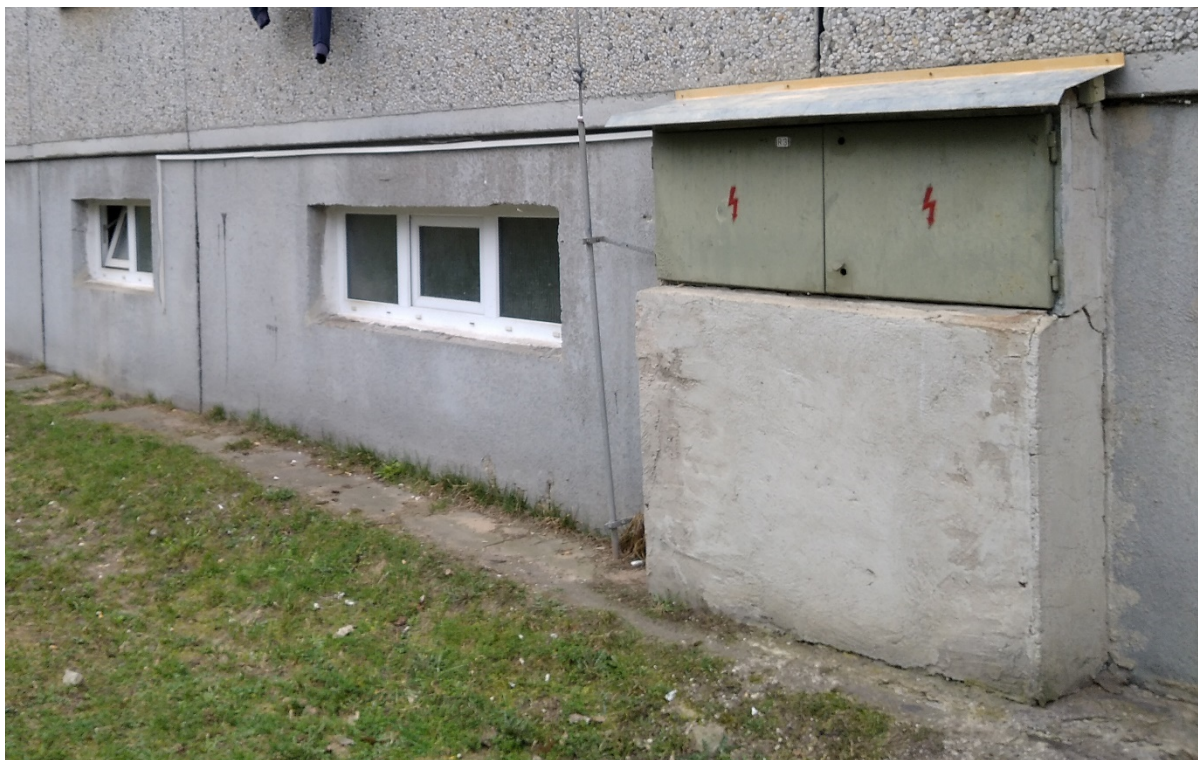
Obrázek 1- Popraskaná obezdívka rozváděče se stávajícím teplotním čidlem a vedením signálu do kotelny
