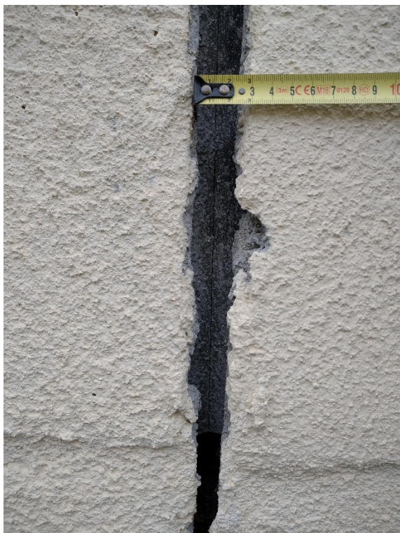
Obrázek 13 - Spára mezi obvodovými panely
